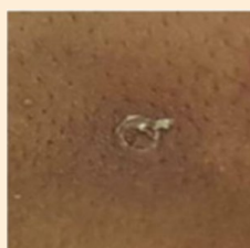
6. Costra parcialmente desprendida
